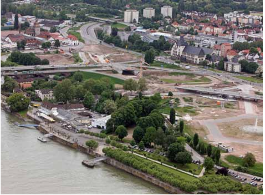
APRIL Die Bauarbeiten an der Zufahrt zur neuen Rheinbrücke schreiten voran.
