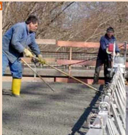
**23** Hier werden, als gesonderte Bauelemente, die seitlichen »Kappen« betoniert, auf denen später Geländer sowie Schutzplanken montiert werden und zukünftig die Geh- und Radwege verlaufen.
