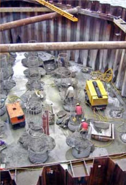
17 Nach Einbringen der wasserdichten Betonsohle kann der Spundwandkasten ausgepumpt werden. Vor den weiteren Arbeitsschritten muss an den Fundamentpfählen der überschüssige Beton per Presslufthammer entfernt werden.
