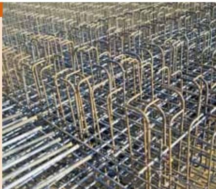
8 Rund 2,5 Millionen Kilo Baustahl werden in der neuen Brücke verbaut. Ein Stab neben dem anderen – Tausende. Jeder am richtigen Platz, nehmen sie die im Beton auftretenden Zug- und Schubkräfte auf.
