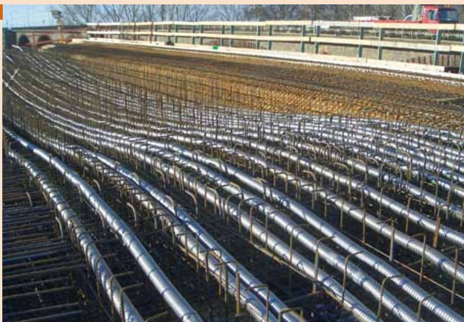
9 Neben der »schlaffen« Bewehrung aus Baustahl wirken zusätzliche, in Leerrohren verlegte, Spannstahlbündel der Durchbiegung des Bauwerks entgegen.
